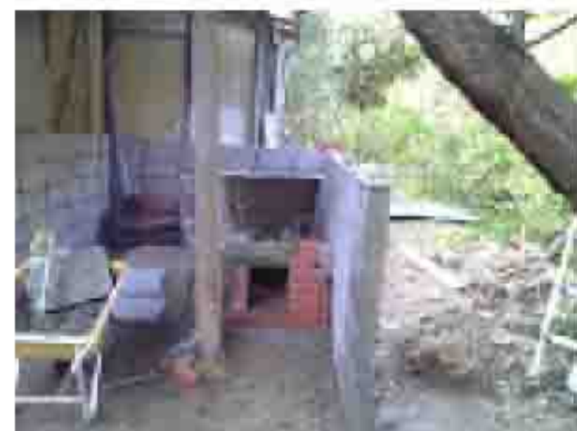
釜底直径くらいに煉瓦を積む 焚き口は前に積む 焚き口支えは 焼き物の釜の6丁掛けの耐火煉瓦を流用した
