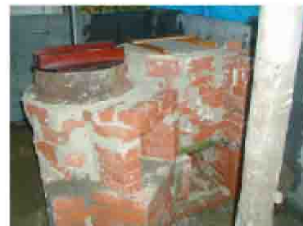
完成 耐火モルタルは 乾いてから不要分はとれる 熱を入れなければ 強度は出ない
