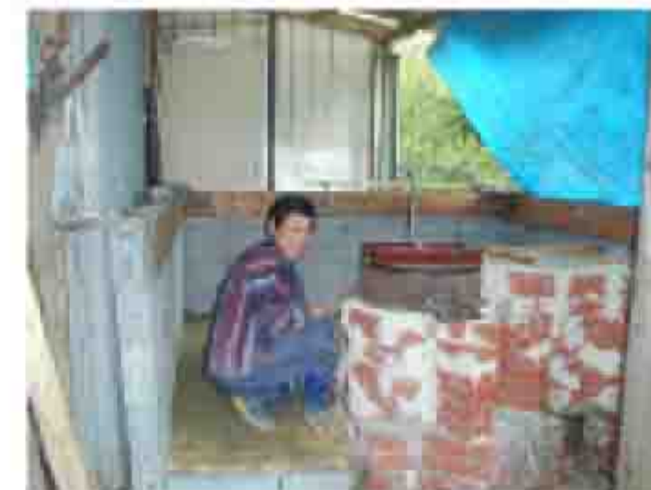
洗い場土間かさ上げ 5月13日 床モルタル
