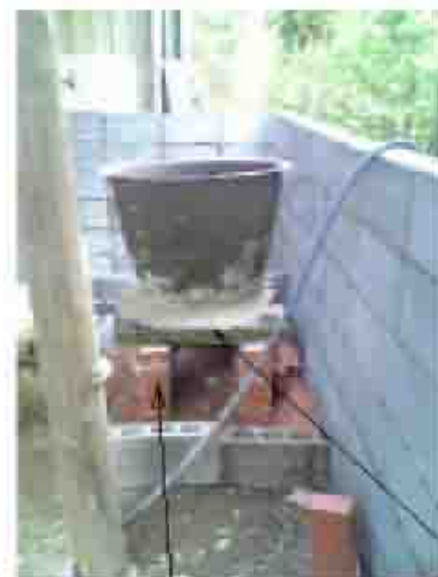
釜底直径くらいに煉瓦を積む 焚き口は前に積む 焚き口支えは 焼き物の釜の6丁掛けの耐火煉瓦を流用した
